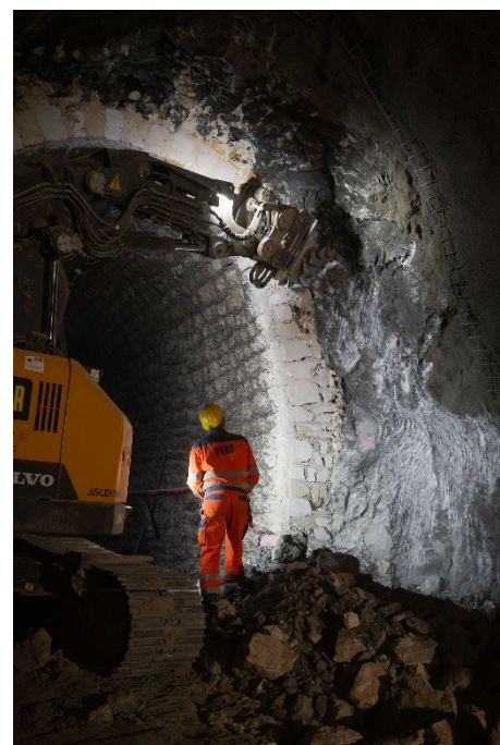
Komplexer Baugrund: Die BLS muss den Weissensteintunnel unter grösstmöglichen Sicherheitsvorkehrungen sanieren.
