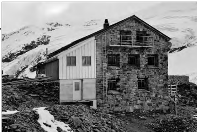
Unsere Mutthornhütte mit dem neuen Toilettenanbau.
